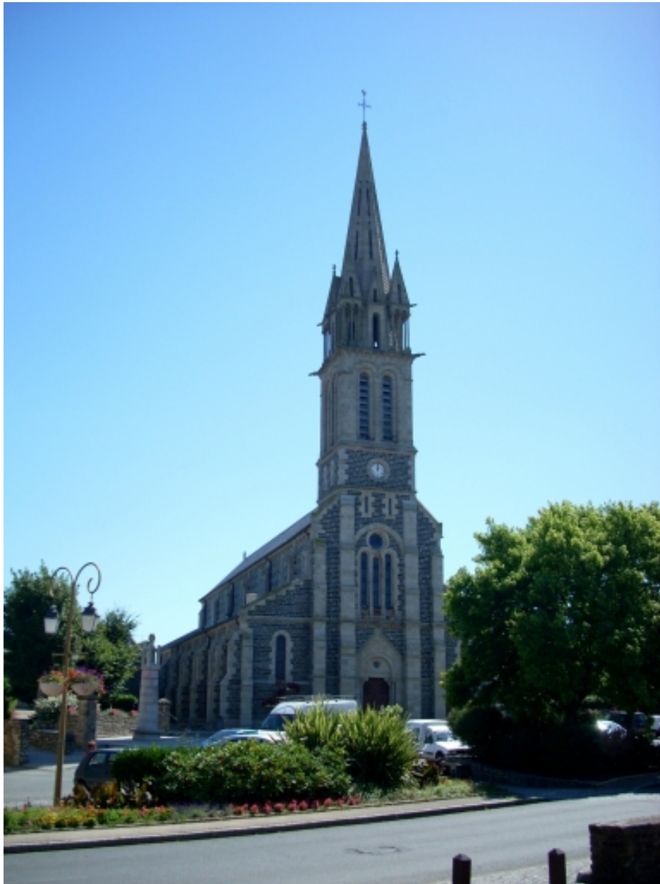
Taulé, église paroissiale Saint-Pierre : vue générale nord-ouest
