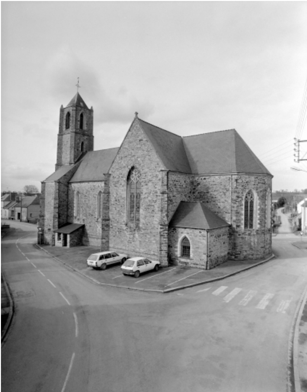
Elévation sud : vue générale
