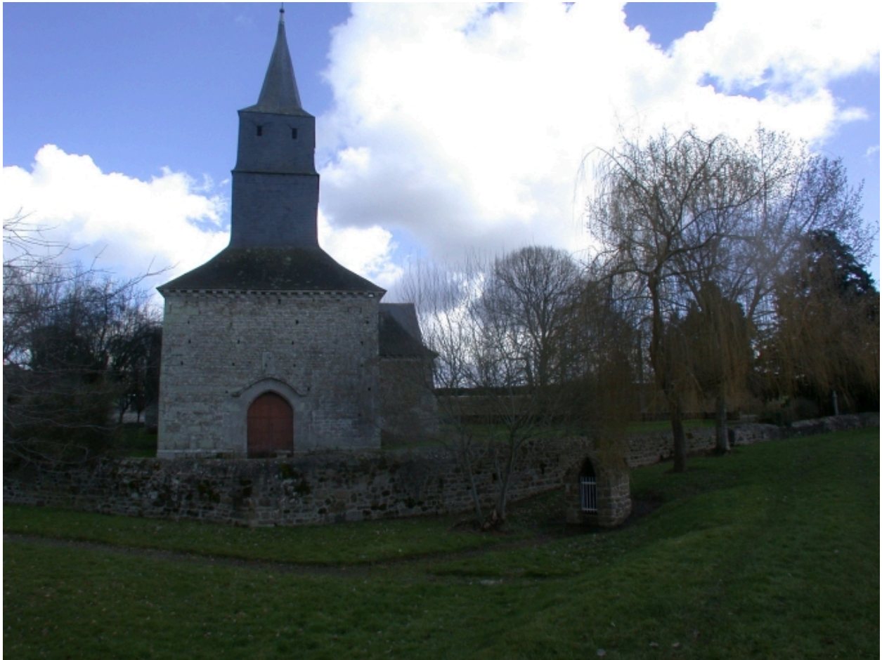
Façade clocher, vue Ouest
