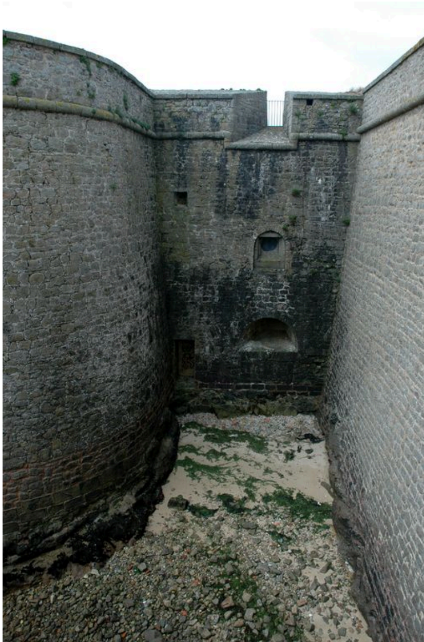
Vue de la citadelle de Port-Louis : embrasures sud protégées par l'orillon du bastion de Groix et flanquant la porte du corps de place
