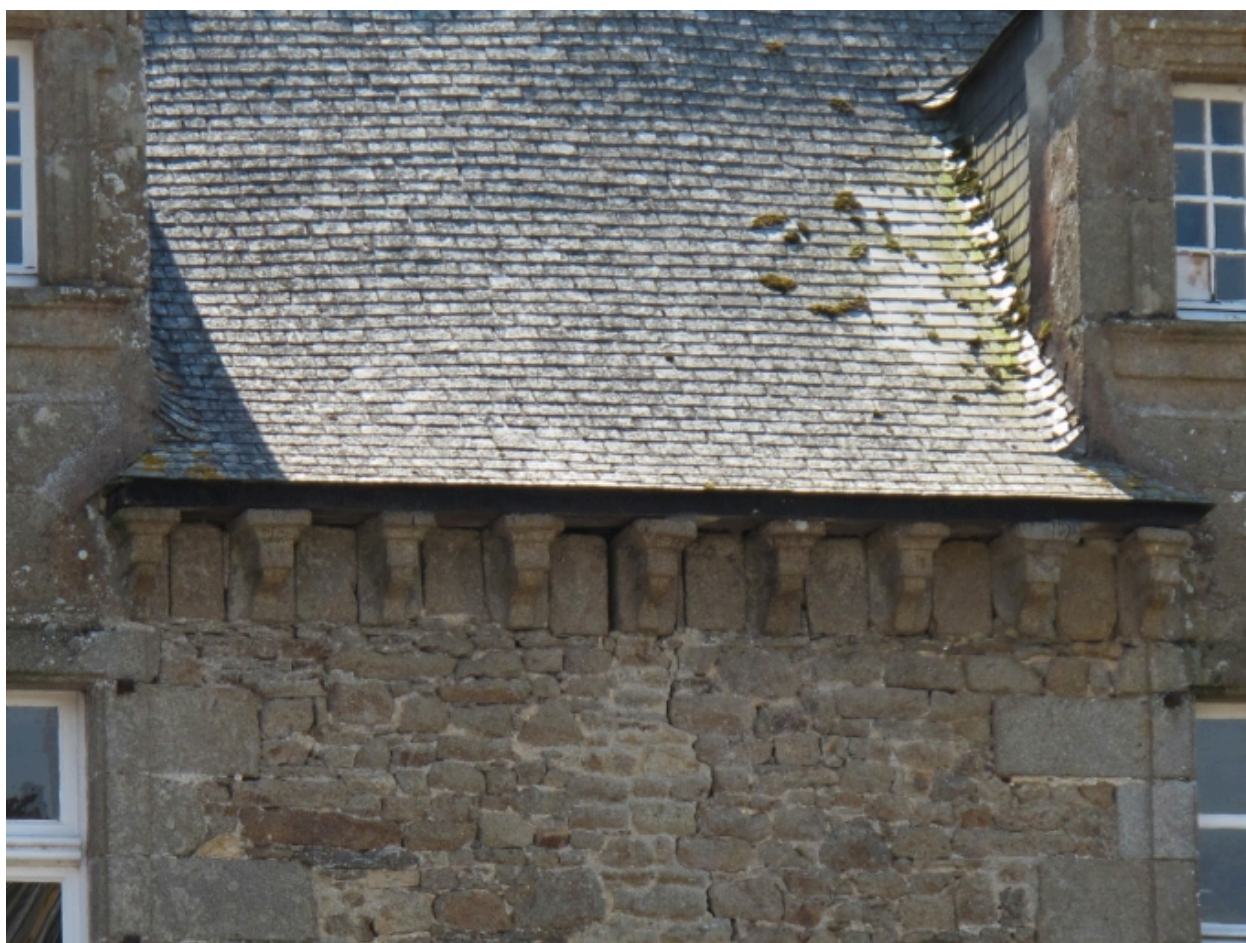
Détail de la corniche
