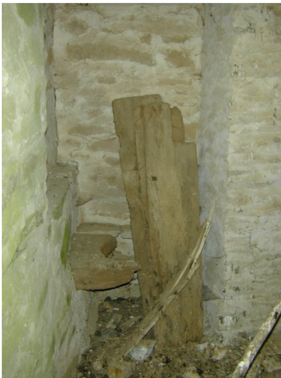
Intérieur, 1er étage, latrines avec son siège de bois
