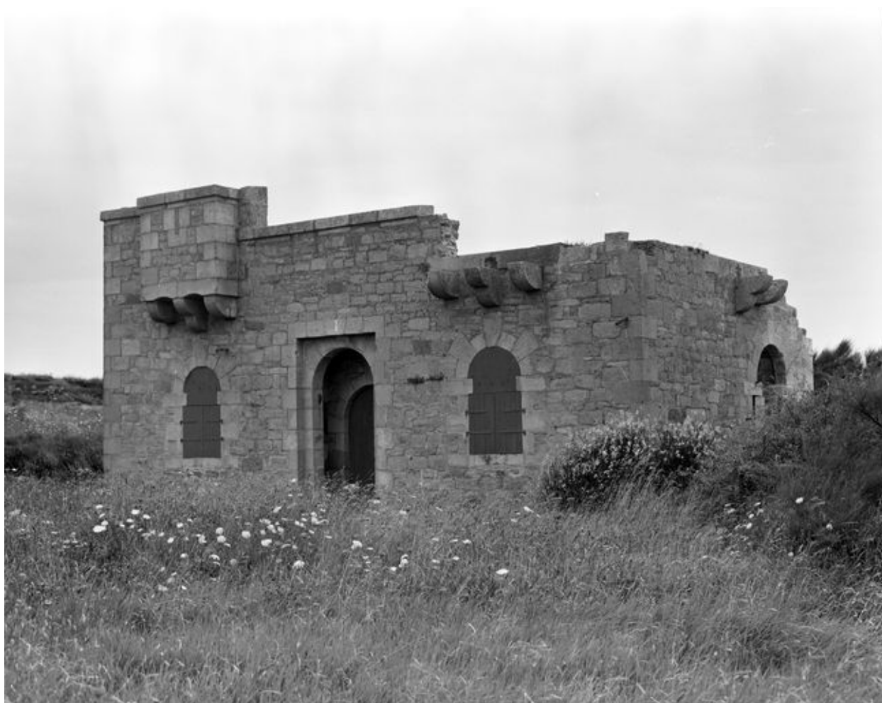
Vue générale : élévation Sud-est (état en 1986)
