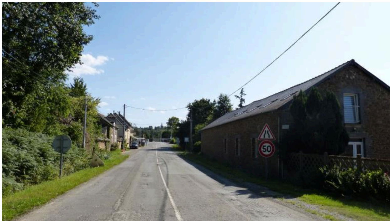
Vue générale nord est d'une dépendance
