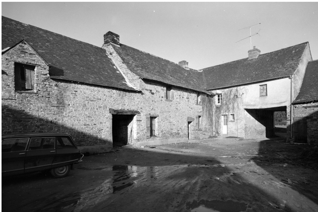
Cour intérieure, vue vers nord est.
