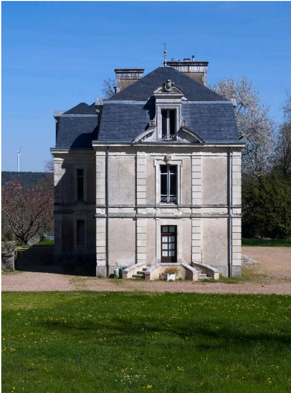
Pignon sud du château
