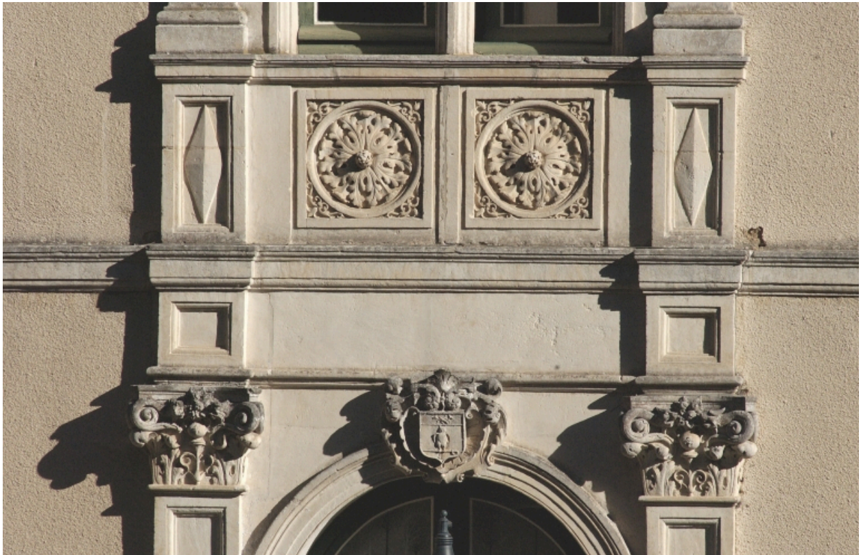
Façade sud : détail de l'allège au-dessus de la porte d'entrée (armoiries)
