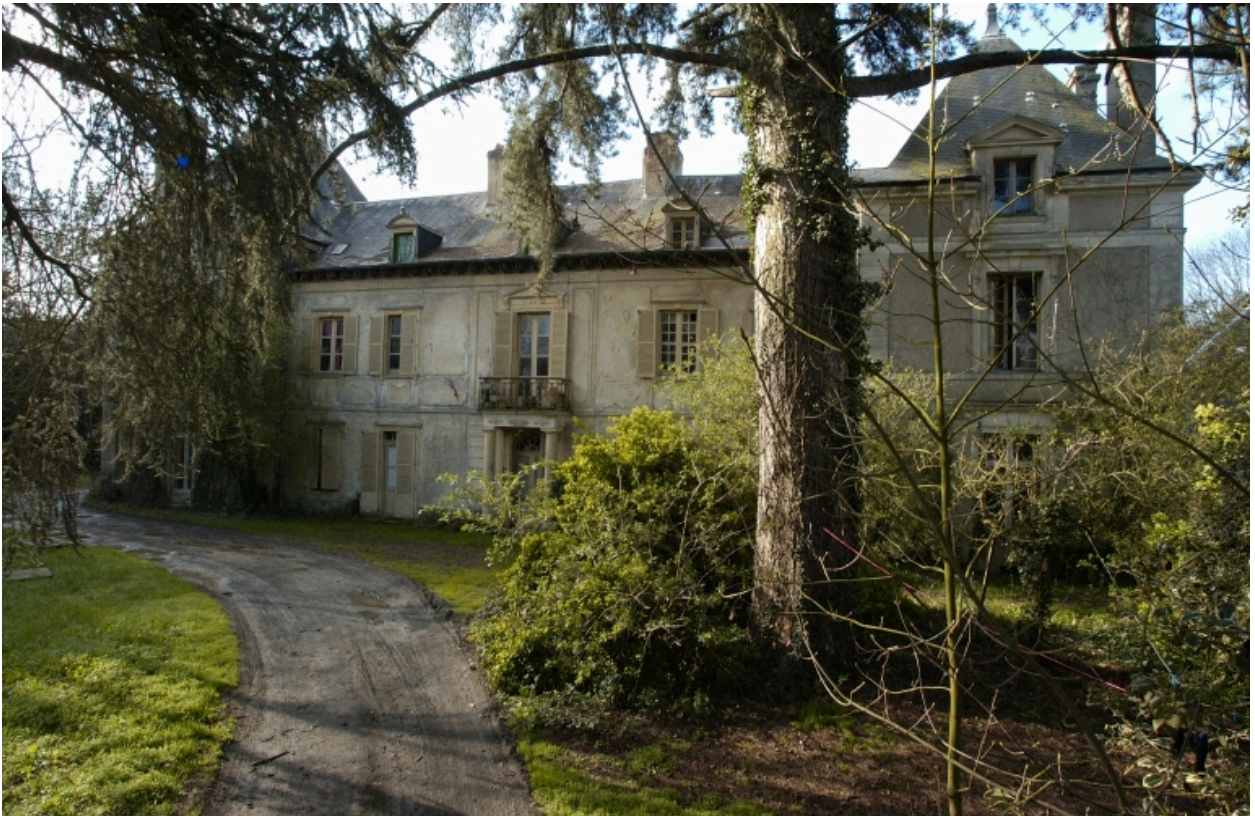
Vue générale nord
