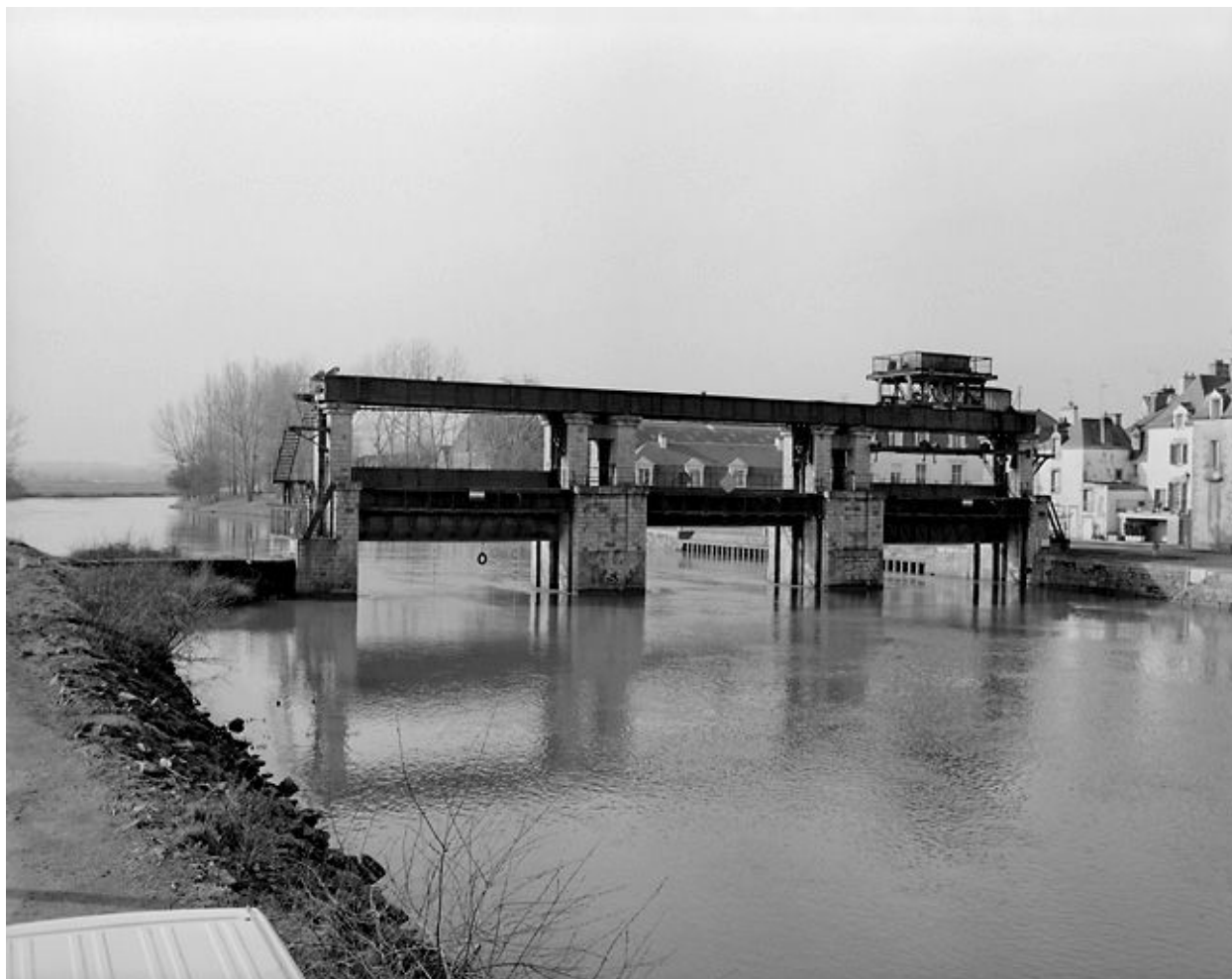
Grand Vannage : vue générale prise du nord
