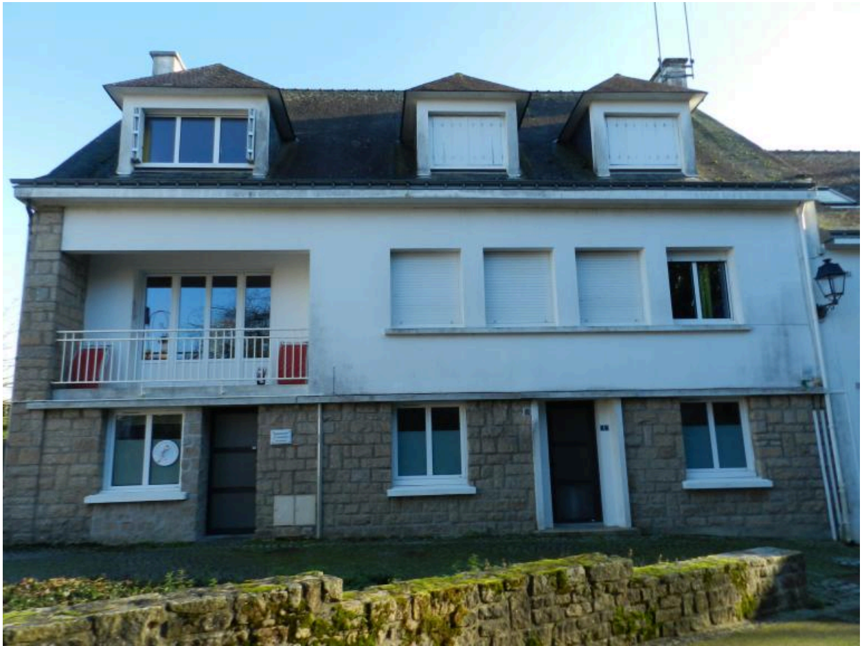
Façade, 1 rue Moricette (Hennebont)
