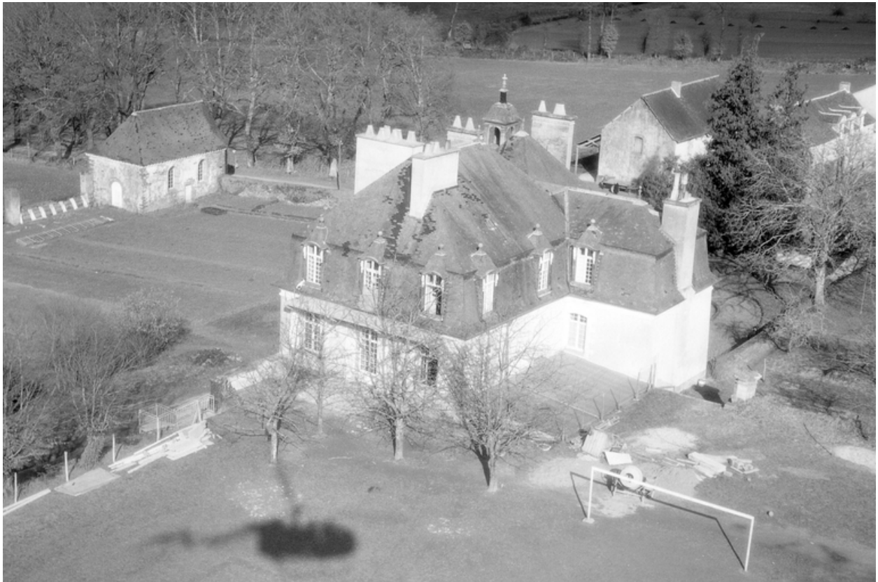
Vue aérienne prise du sud-ouest.
