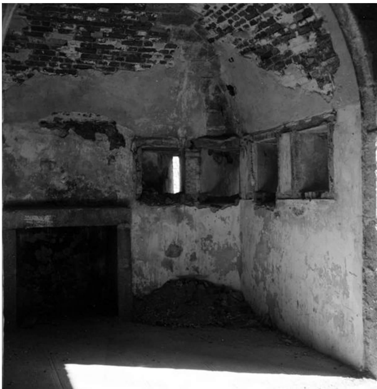
Camaret-sur-Mer, pointe du Toulinguet : vue de la tour-modèle n° 3 en 1969, chambrée au deuxième niveau, cheminée et créneaux de fusillade
