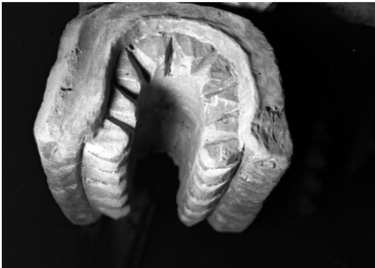
Charpente, détail de la clé 10.
