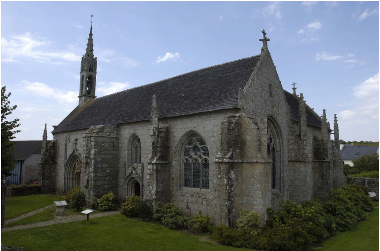
Vue de trois quart du chevet et de l'élévation sud
