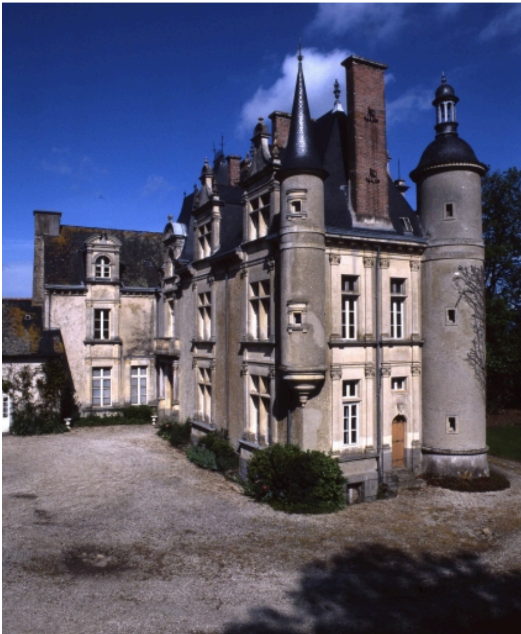
Vue générale du pignon est
