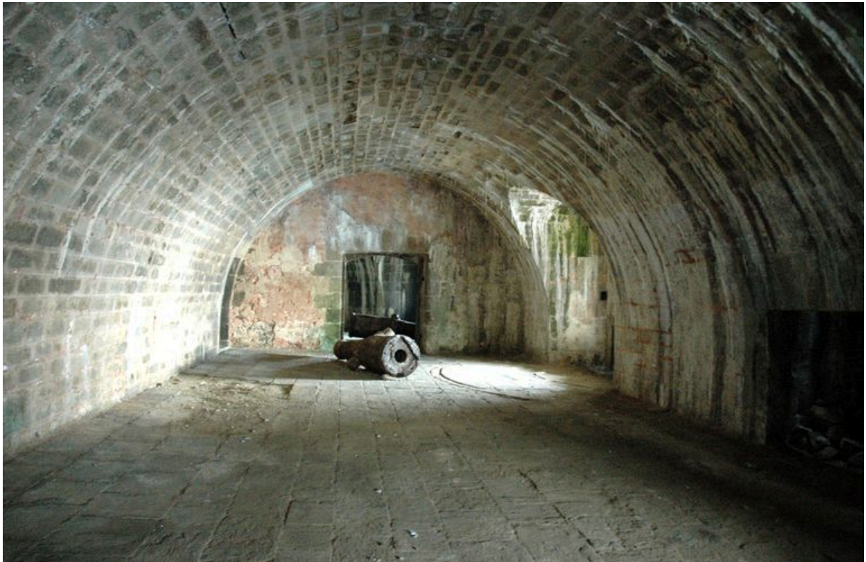
Vue du fort de la Conchée : casemate (n° 1) dit souterrain à deux embrasures. Tube de canon (b) à chargement par la culasse.
