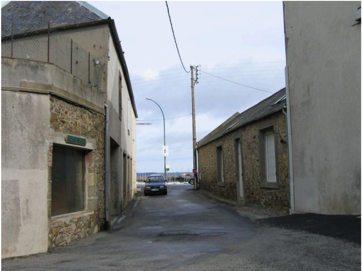
Elévation latérale de l'ancienne conserverie
