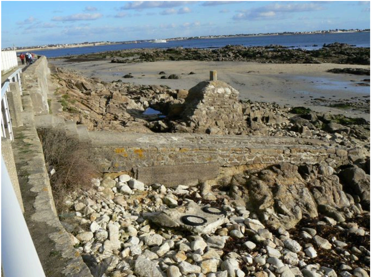
Vue latérale de la rampe et de la borne géodésique du fort de Locqueltas
