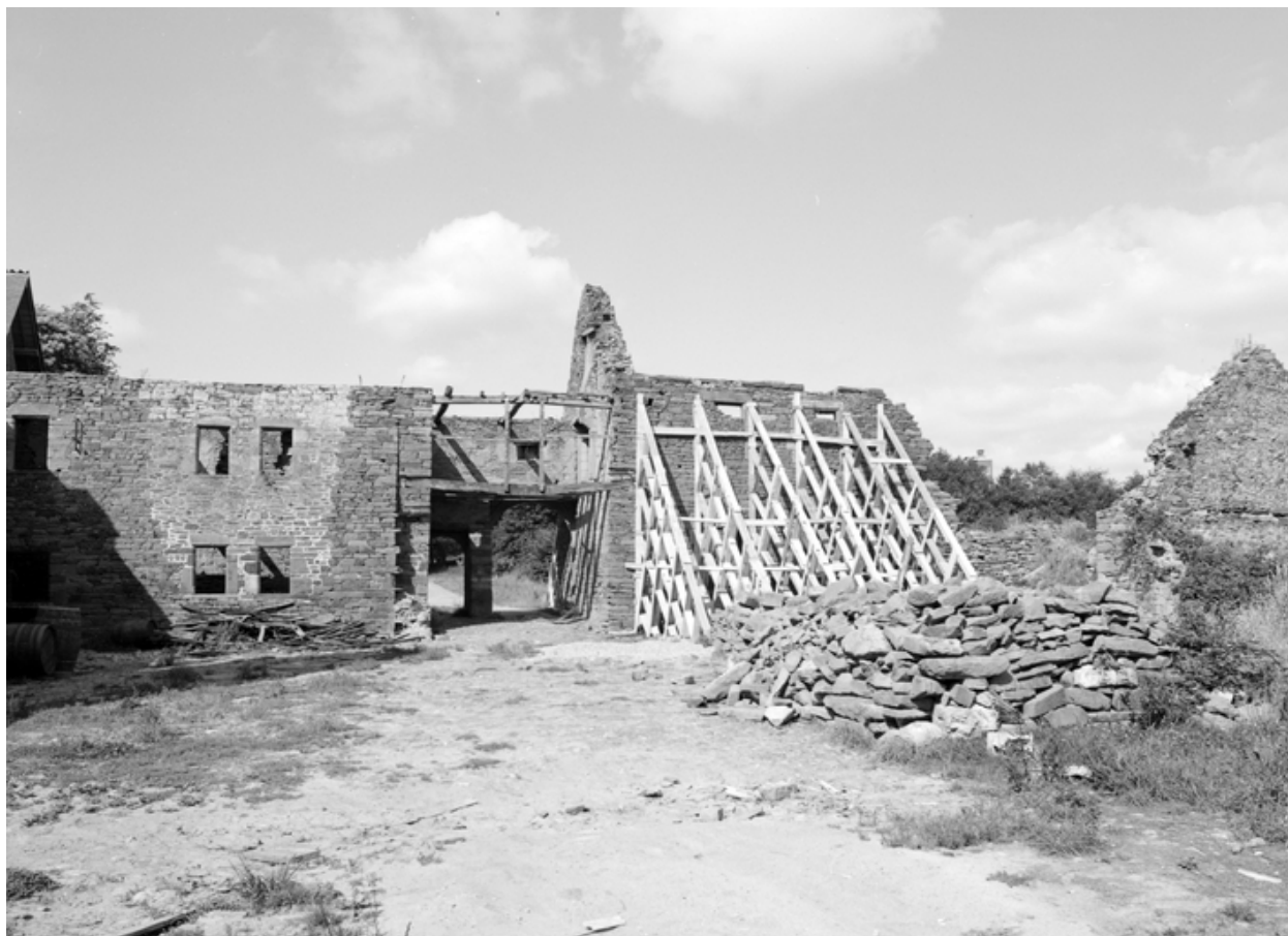
Bâtiment de l'entrée : élévation nord-est
