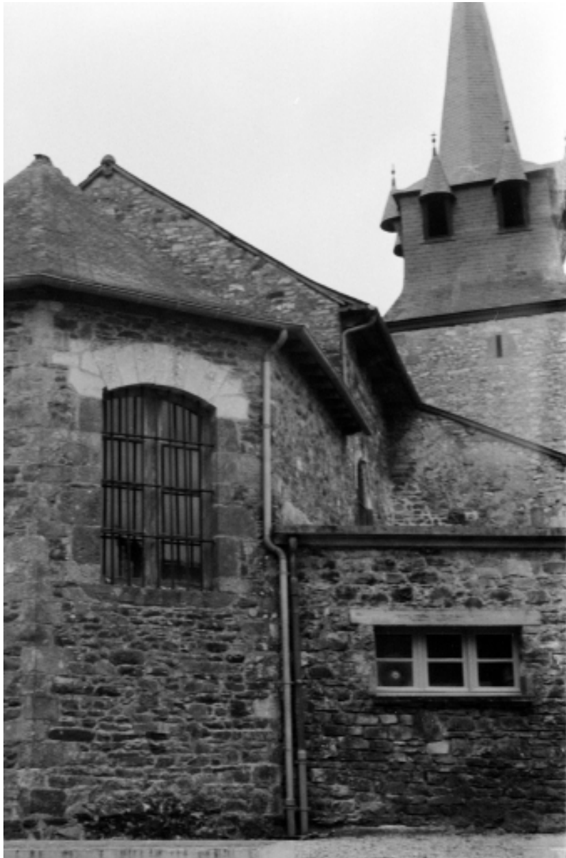
Nord-est de l'édifice, prise de vue de 1970
