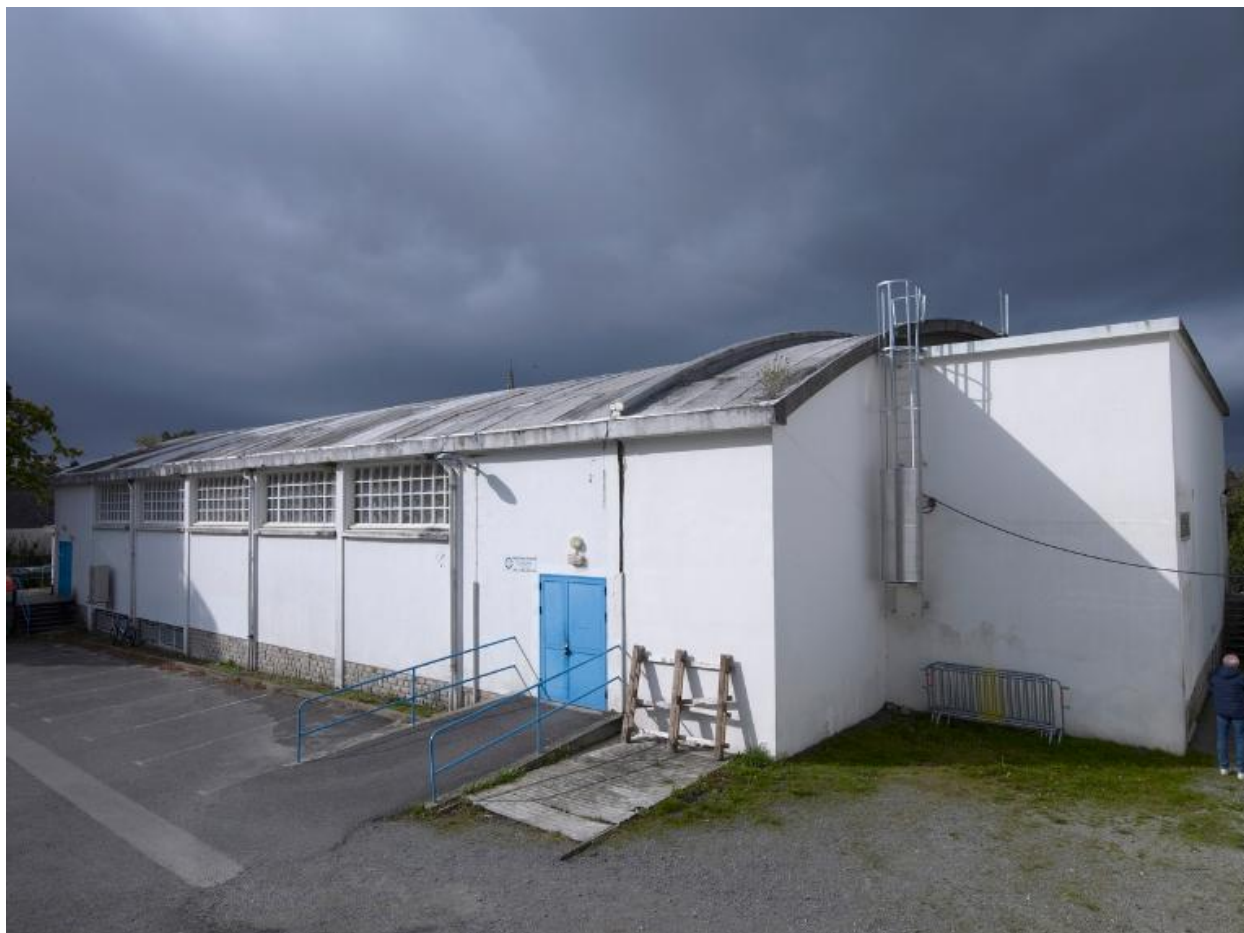
Vue générale prise du nord-est
