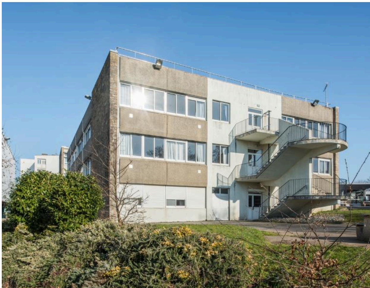
Externat du collège, façade sud. Sylvain Malizan, architecte, 1984.
