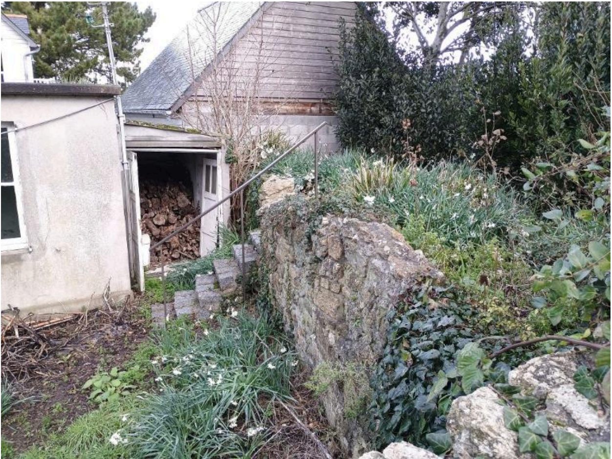
Vue des vestiges du mur de soutènement de la digue dans la parcelle section CA, n° 559 depuis la parcelle CA, n° 558
