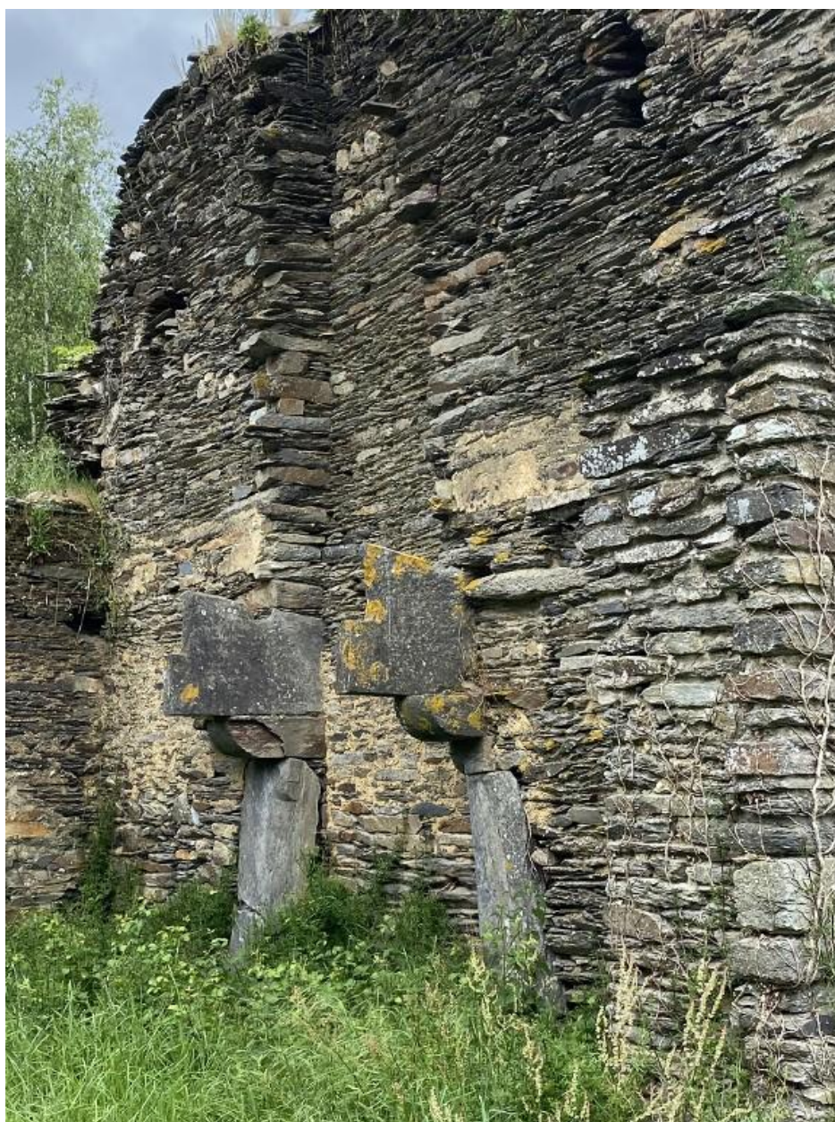
Ancienne cheminée côté est.
