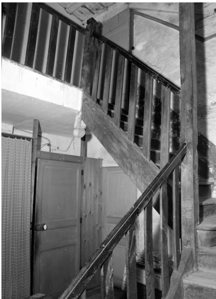
10 rue du fil, escalier, détail.
