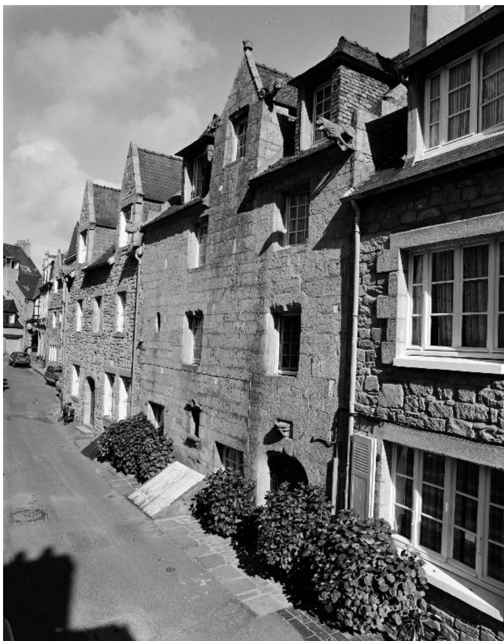
19 rue Armand Rousseau, élévation nord, vue générale
