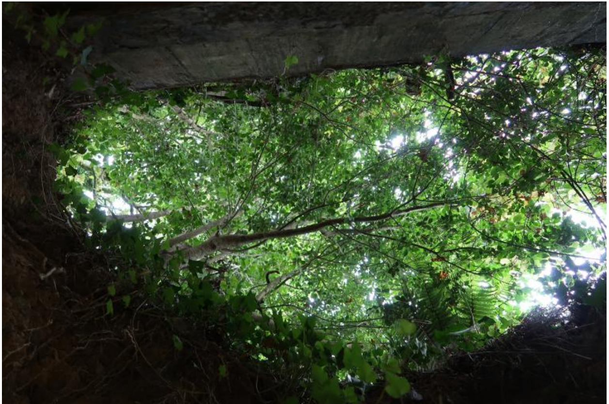
Vue de l'entrée ouest en partie remblayée et envahie par la végétation depuis l'intérieur du bunker (état en 2021)
