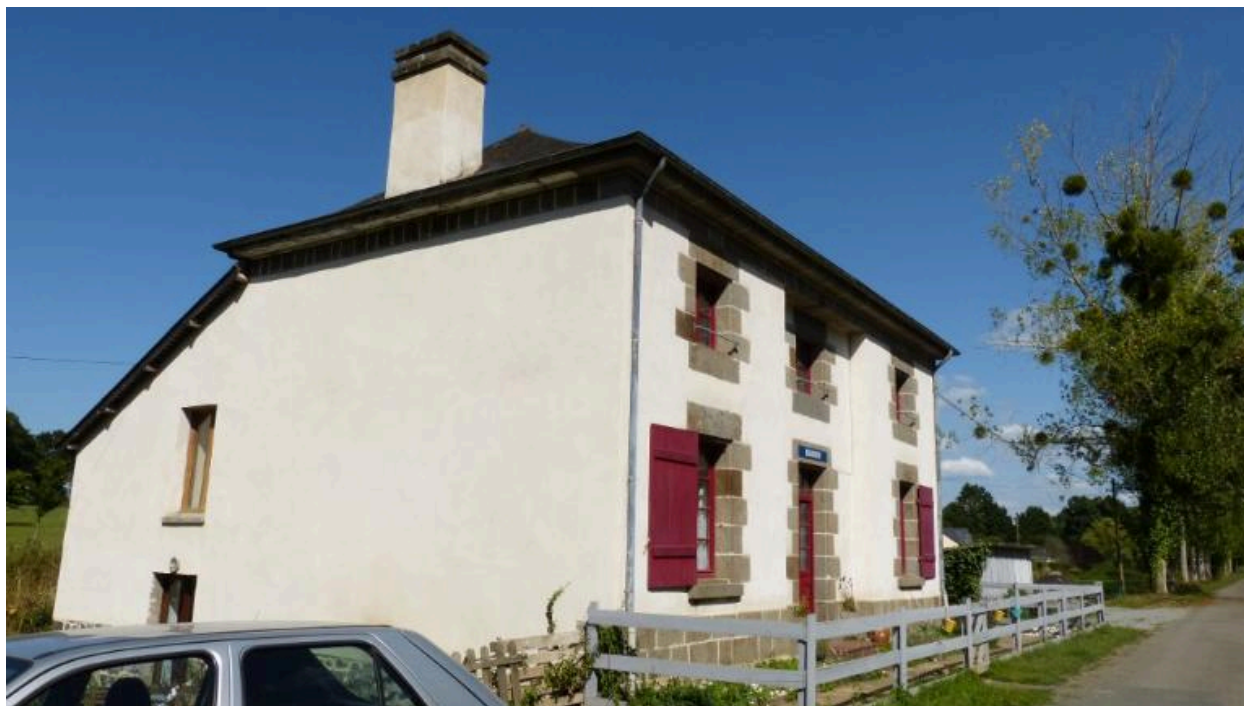
Vue sud ouest
