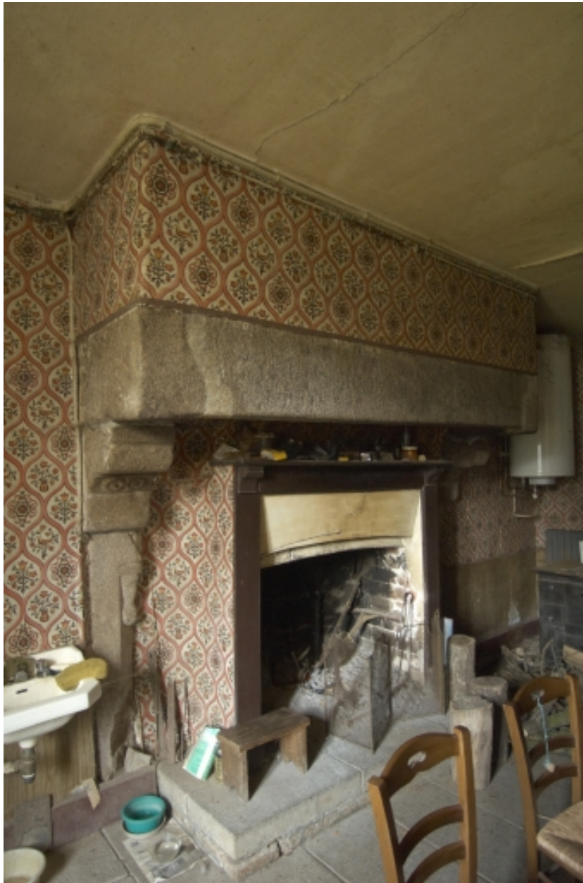
Cheminée monumentale de la cuisine
