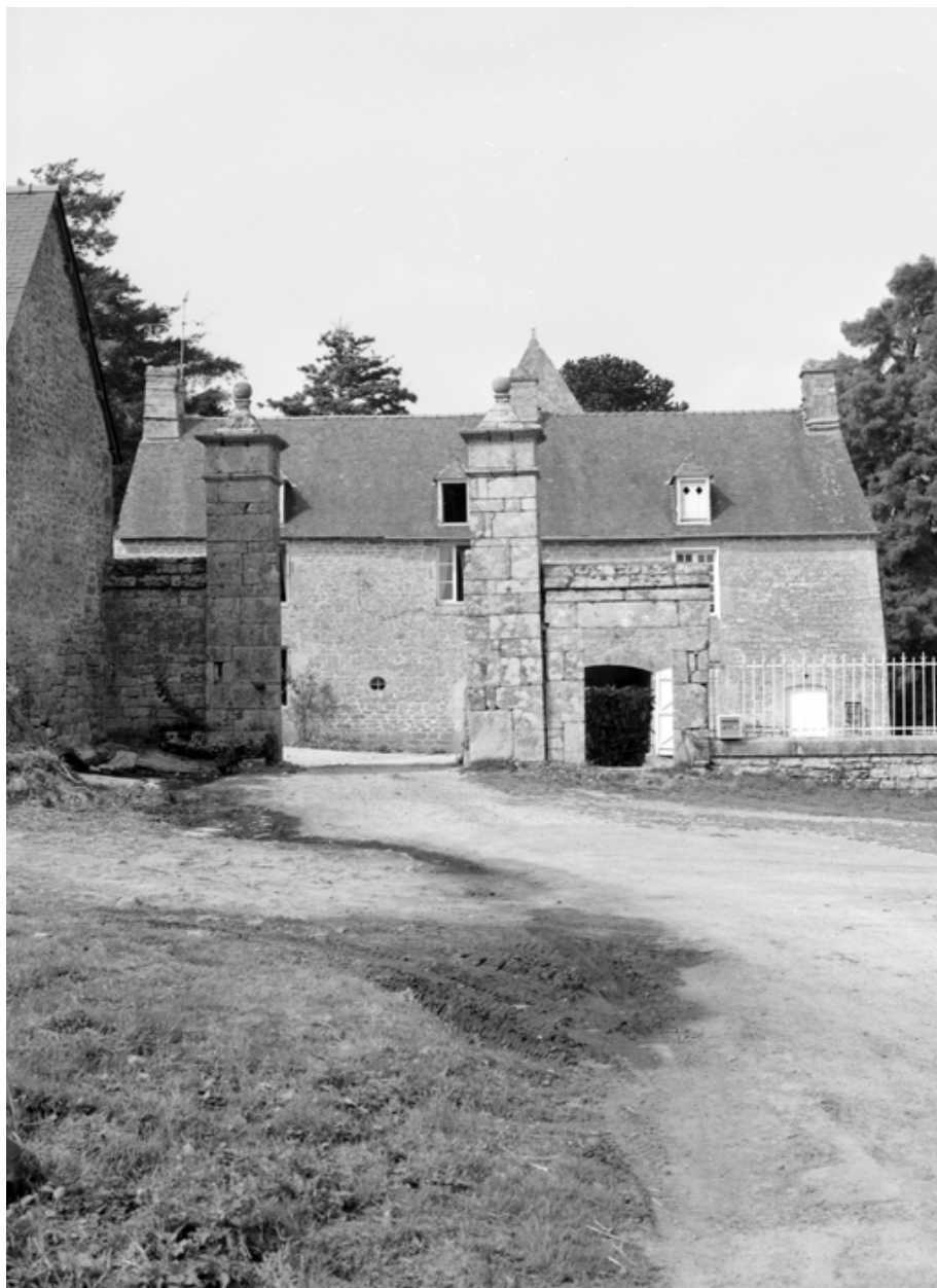
Portail : accès à la cour.
