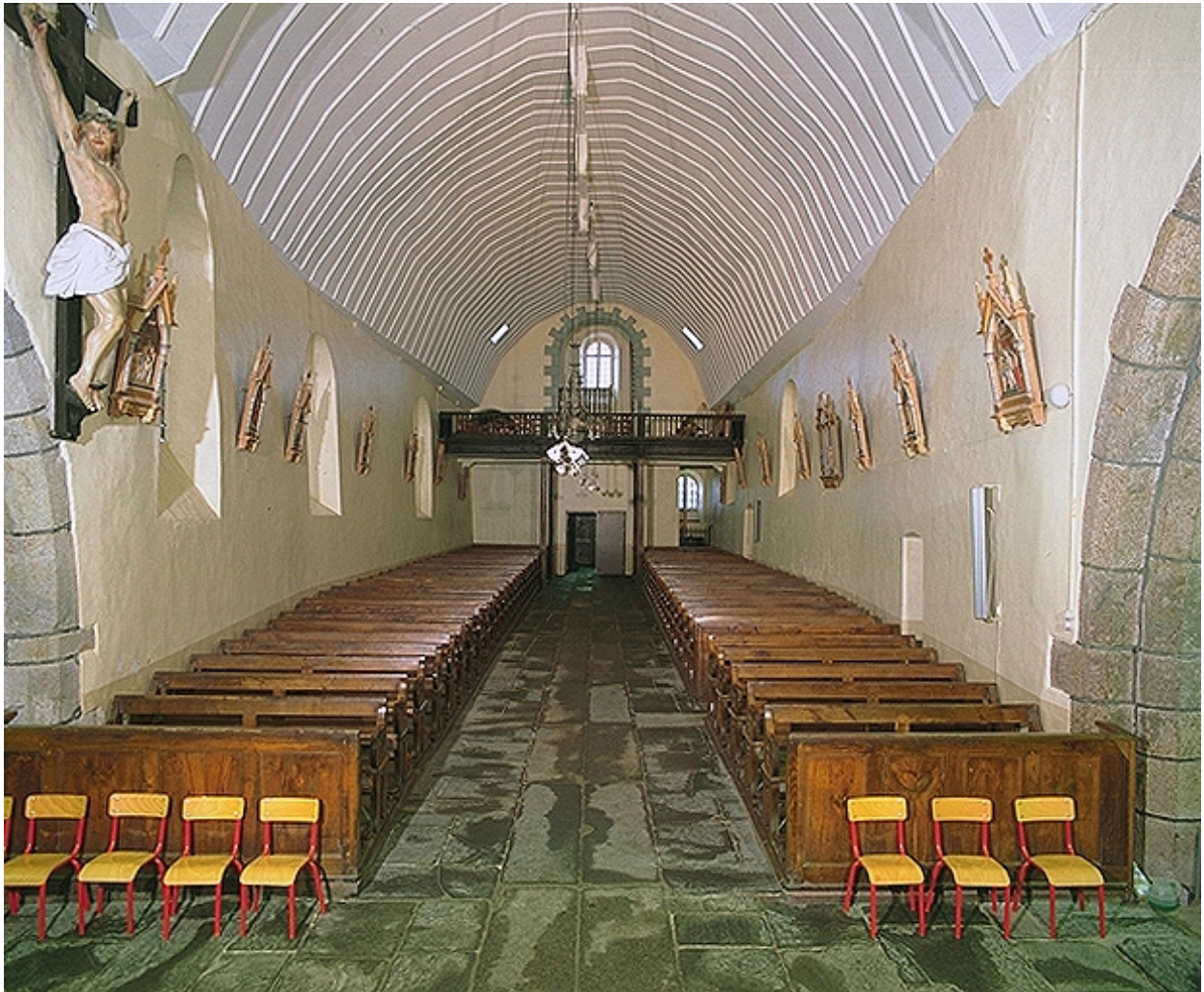
Vue générale vers la nef
