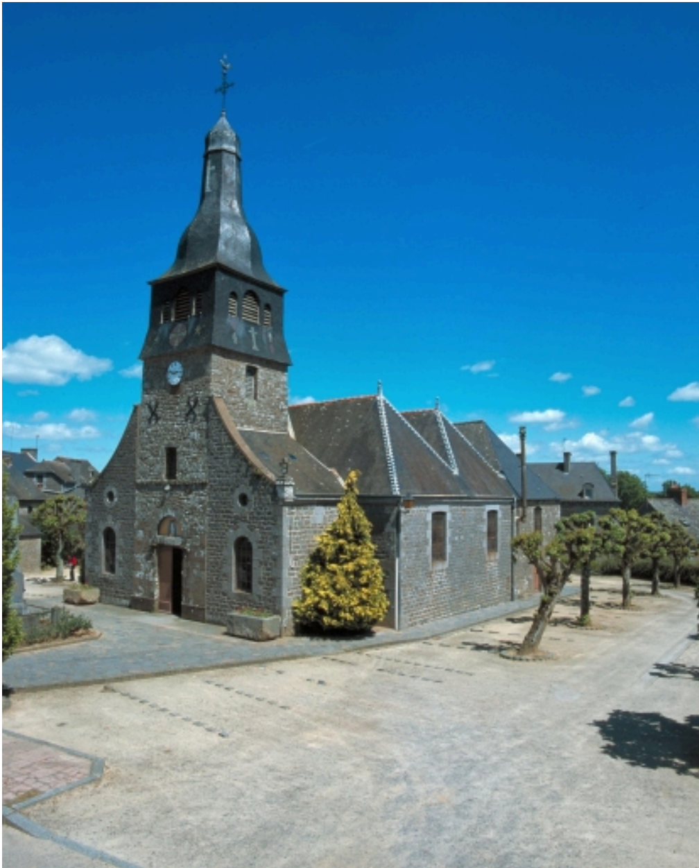
Vue générale sud-ouest (état en 2001)
