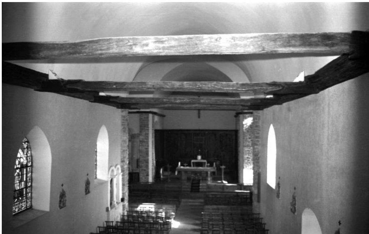
Entraits à engoulants de la nef, état en 1972
