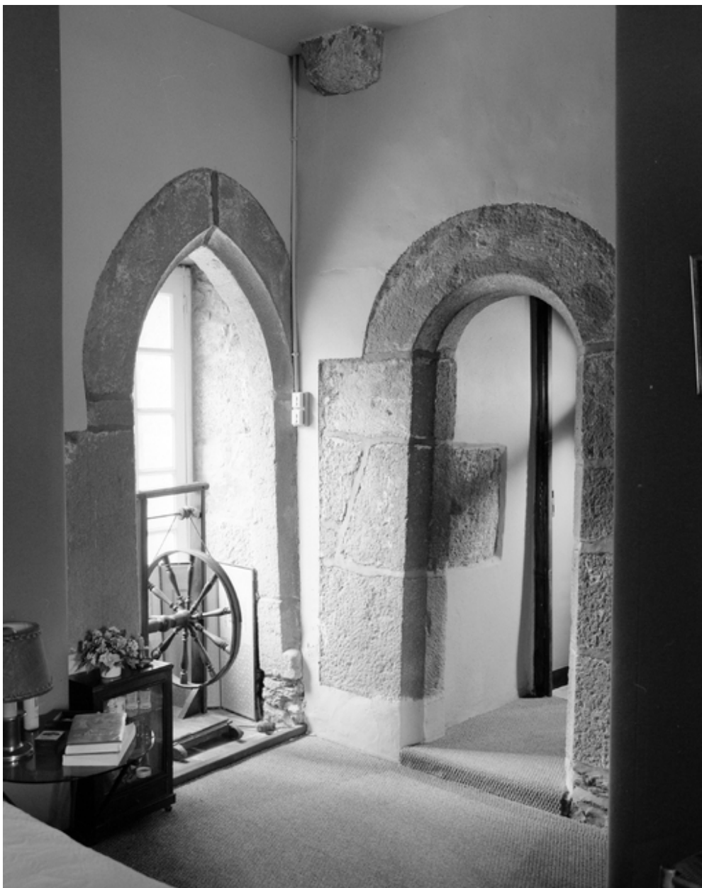
Logis, pièce 8 : doubles portes.
