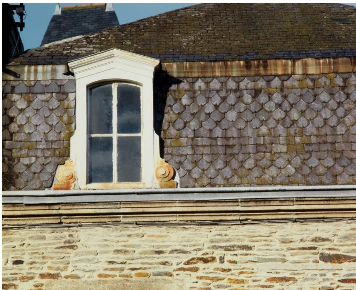
Rue Madame : lucarne de la fin 19e siècle (état en 1988)
