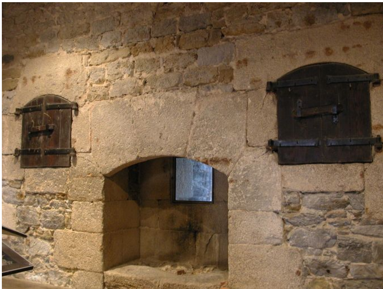
3e niveau : cheminée disposant d'un créneau de mousqueterie
