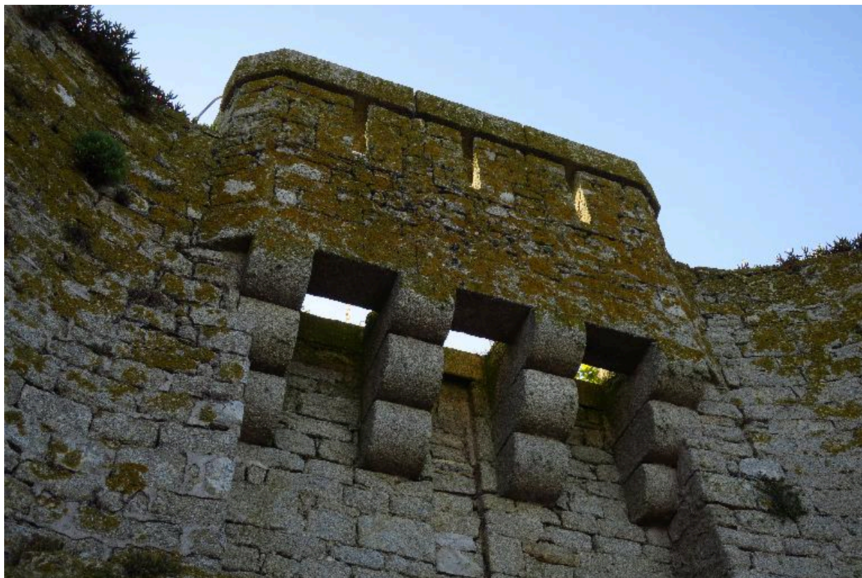
Archipel de Glénan, fort de l'île Cigogne, bretèche surmontant la porte.
