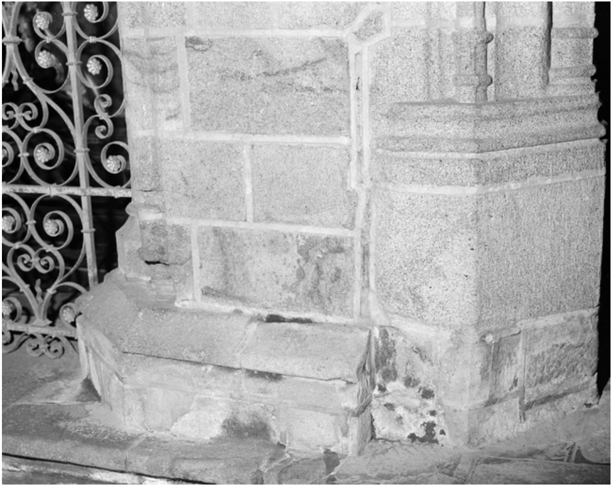
Choeur, partie est, 1ère pile nord, base
