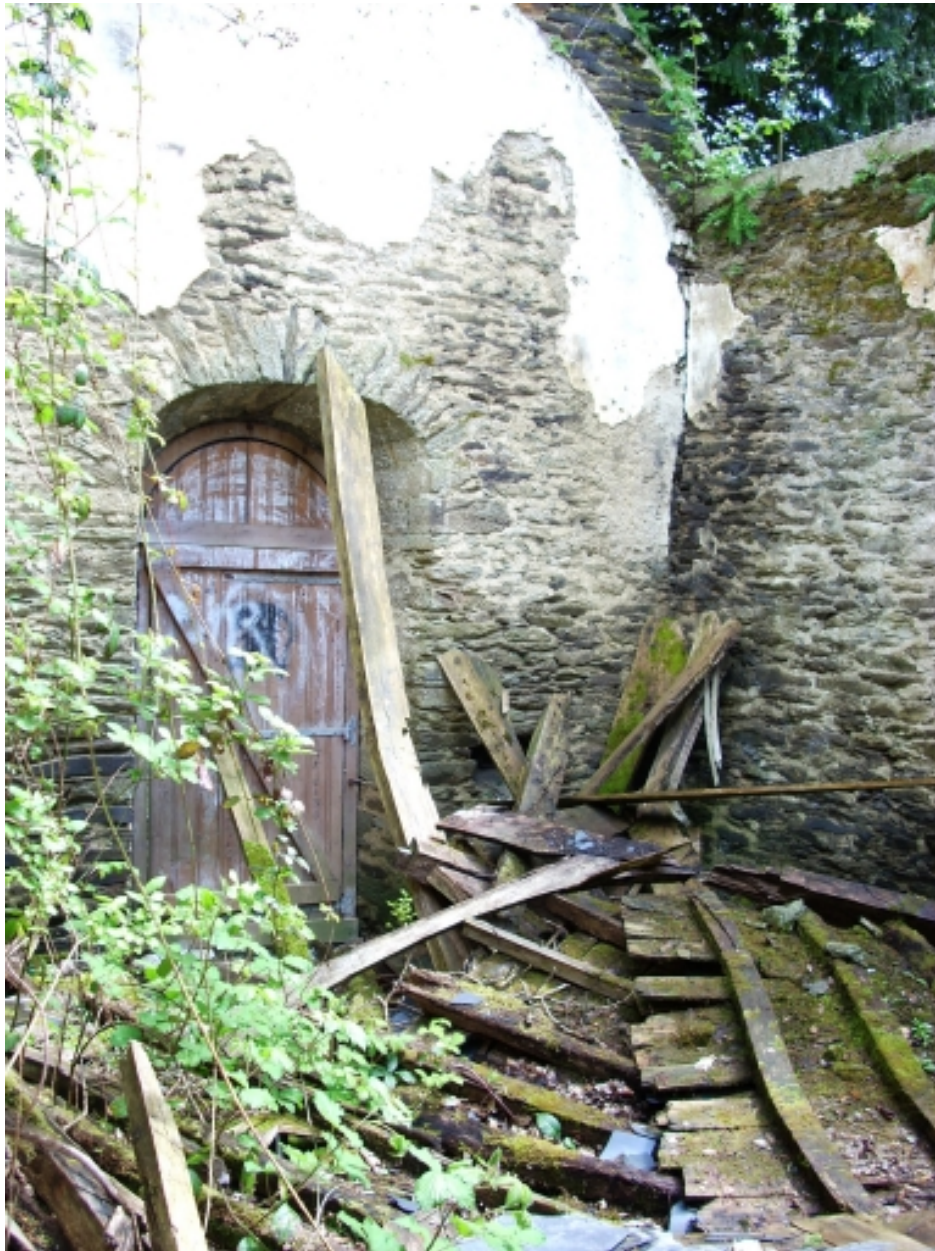
Carhaix, chapelle de la Salette : vue transversale sud-ouest
