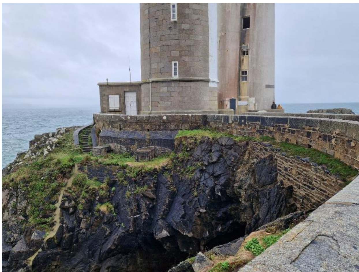
Vue de situation des deux niches à munitions implantées au nord du phare du Minou
