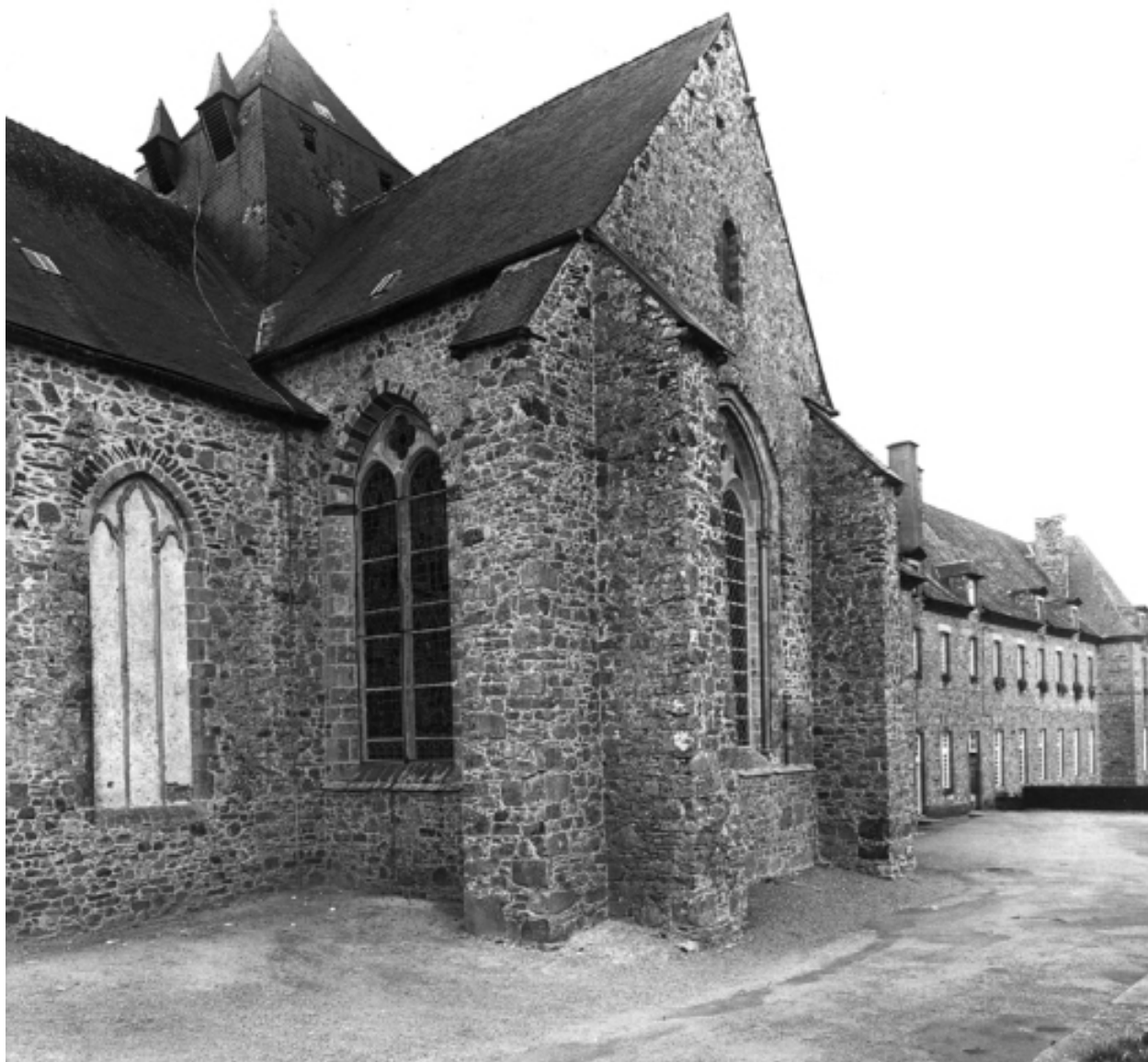
Eglise ; chevet, vue de situation
