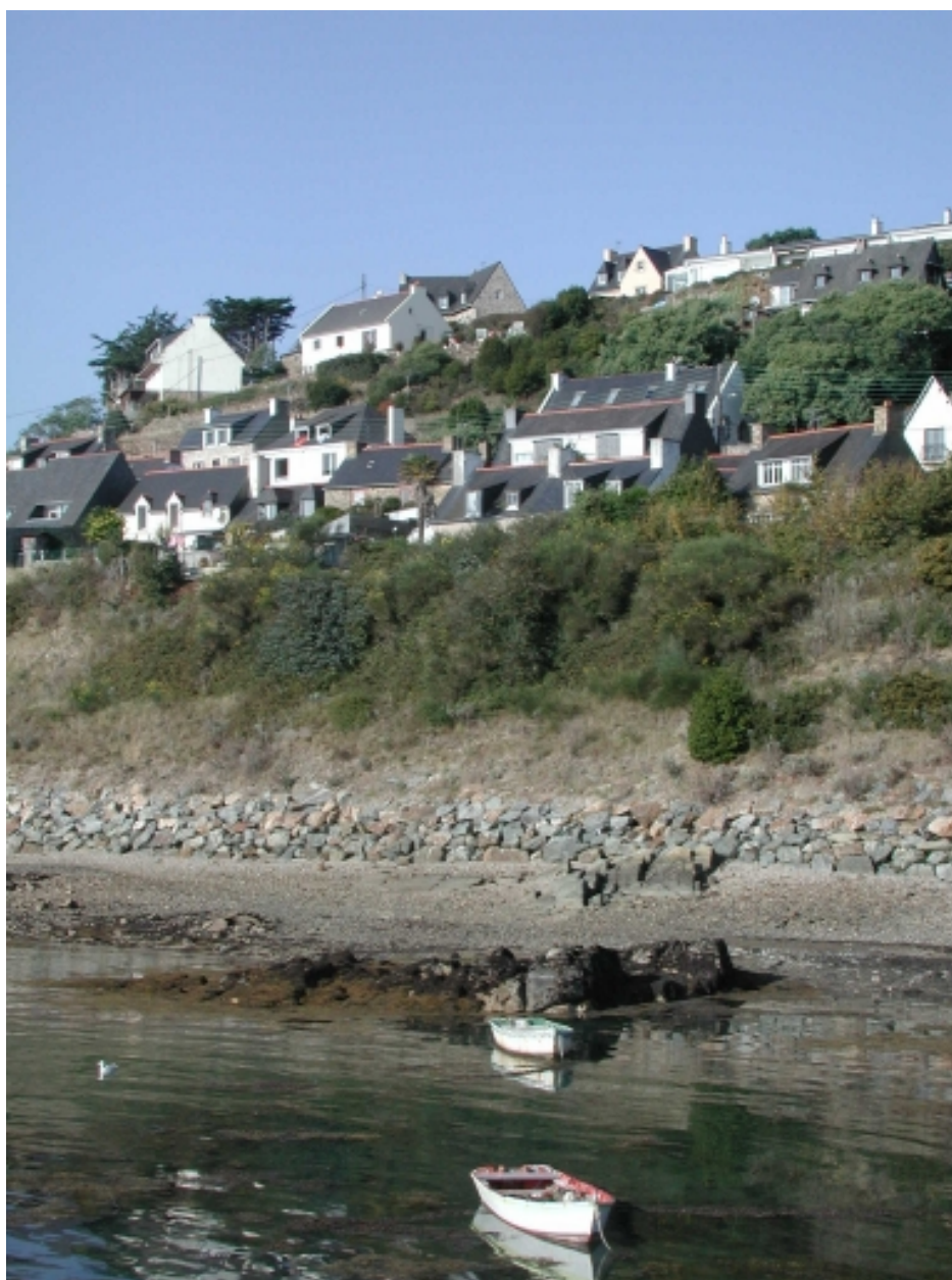
Vue du front de mer urbanisé et des enrochements
