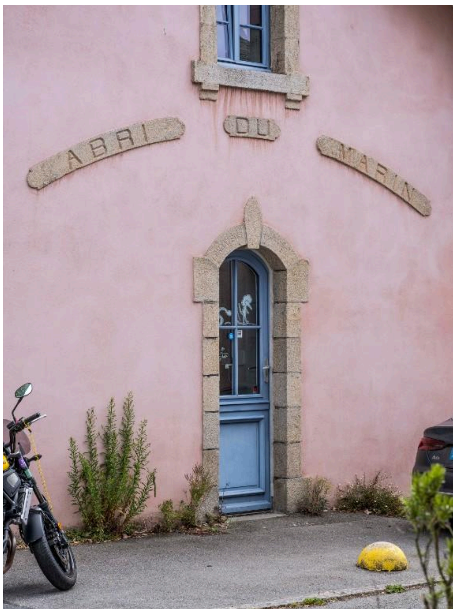
Ancien abri du marin : ouverture et inscription sur élévation sud-ouest
