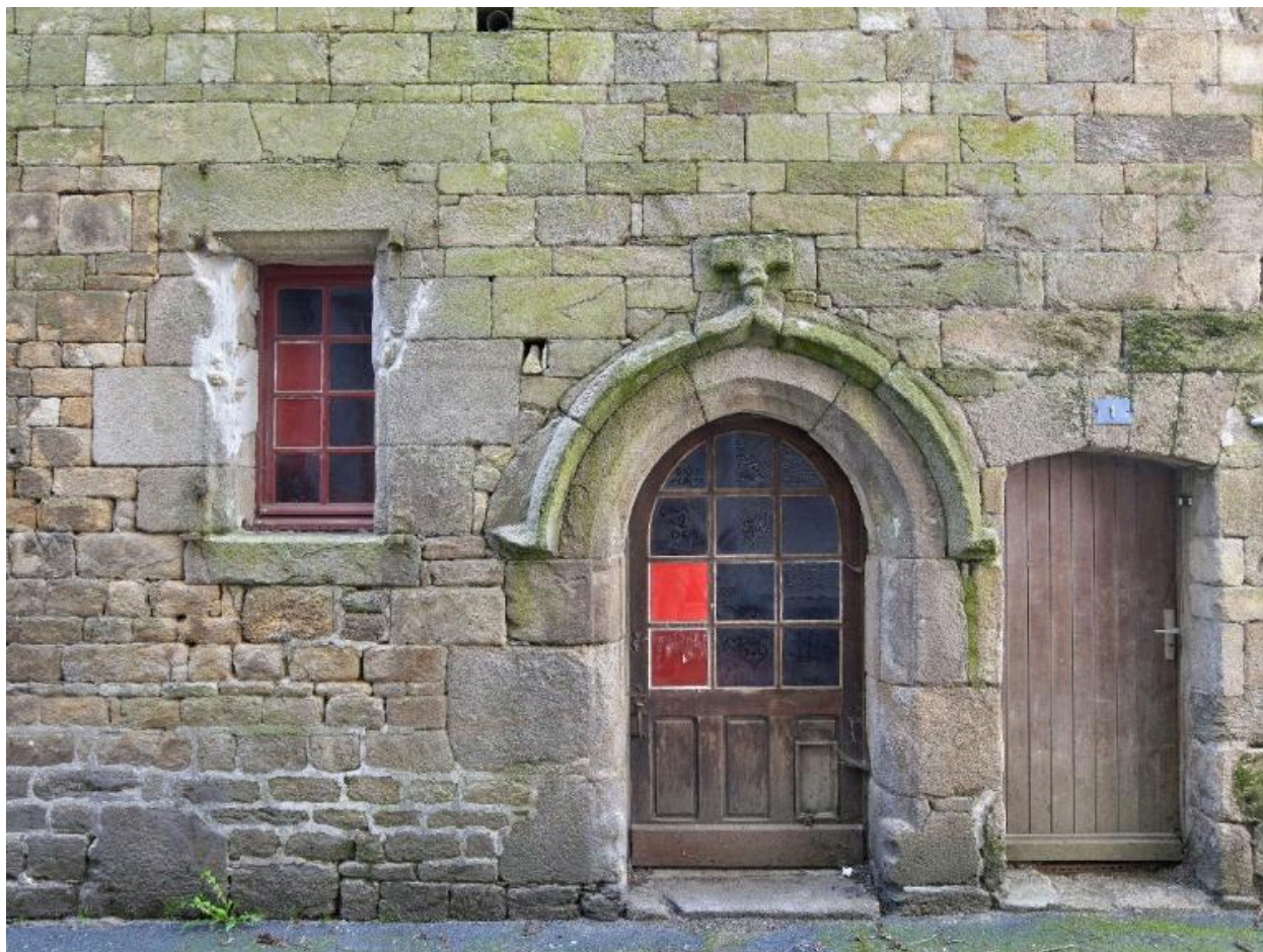
Ensemble d'ouvertures dans le gouttereau rue du Cosquer : fenêtre avec chanfrein et feuillure, porte moulurée avec cordon et fleuron, porte à linteau surbaissé.
