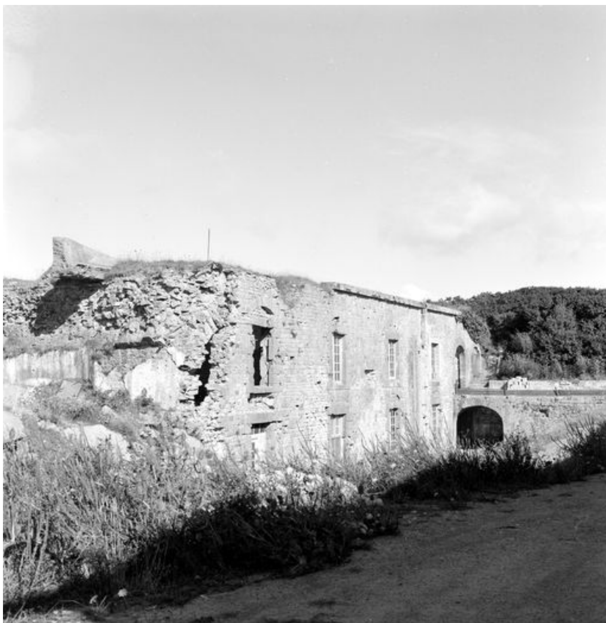
Roscanvel, fort de Quélern, caserne casematée, 1854.
