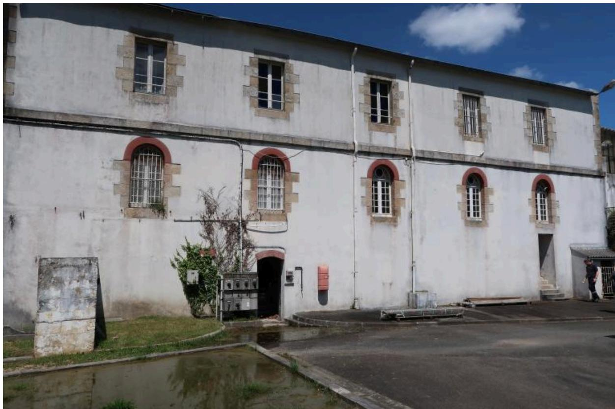
Vue générale : élévation sud (état en 2022). Au premier étage, fenêtres à linteau en arc segmentaire ; au deuxième étage, fenêtres à linteau droit ; entre les premier et deuxième étages, bandeau en granite
